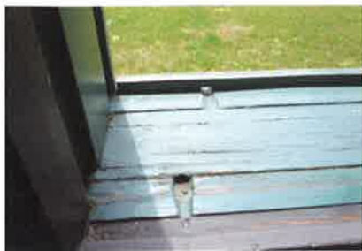
窓枠の溝（結露水の排水？）
