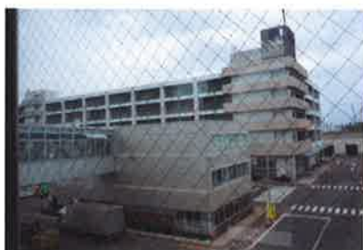
管理センター棟と立体駐車場
