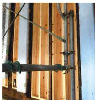
外部からみた補強状況
