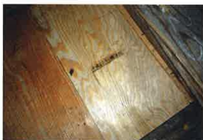
「平成25年 補強材」と記された焼き印
