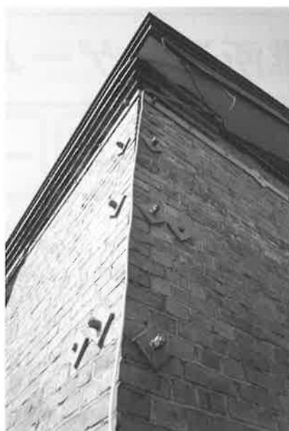
レンガ積の外壁 —アンテナショップ廻りは補強されている—
