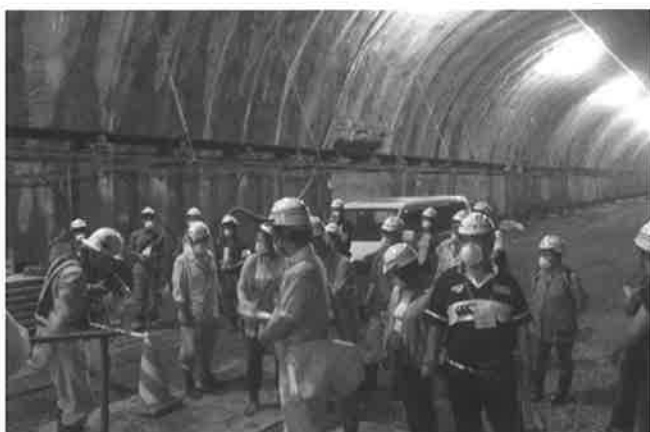
◀トンネルの中
