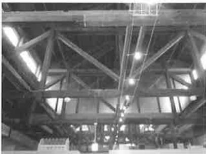
れんがの館 (旧日本食品製造合資会社工場) 内部
