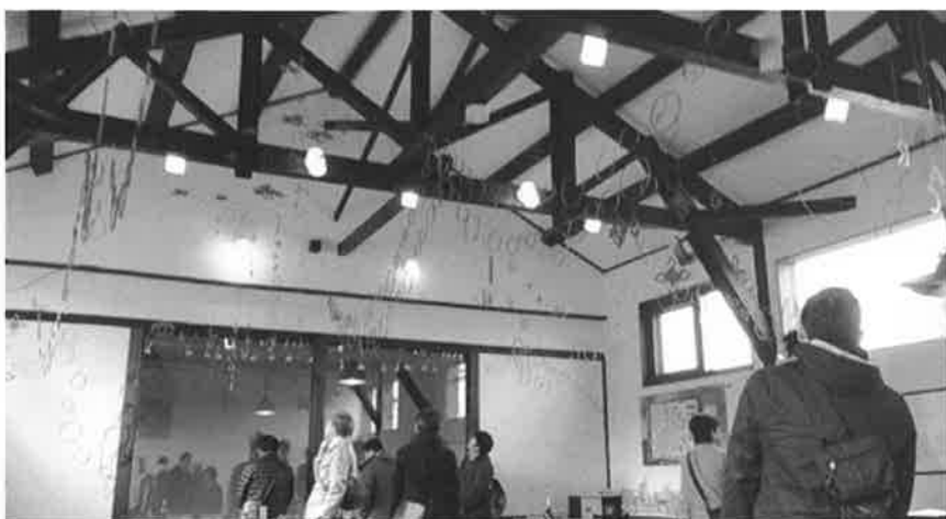
トラスの軸組みが美しい2階のホール
