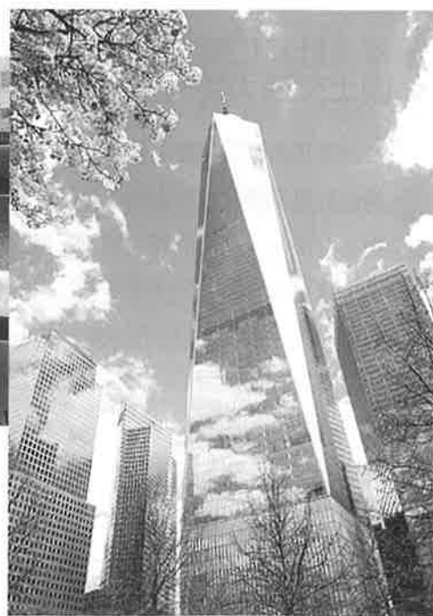
▲ ワールドトレードセンター・タワー 1
